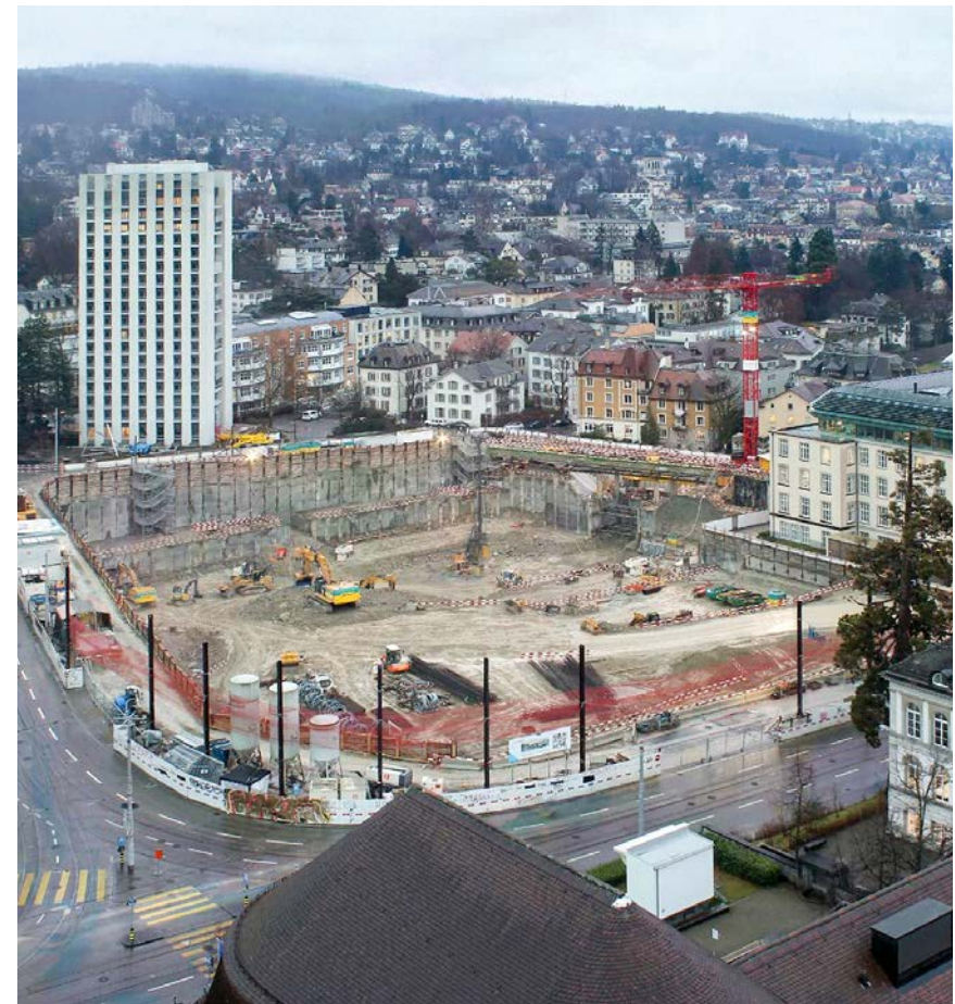
Hier entsteht die Zukunft: Aushubarbeiten für das FORUM UZH auf der Wässerwies an der Rämistrasse.
